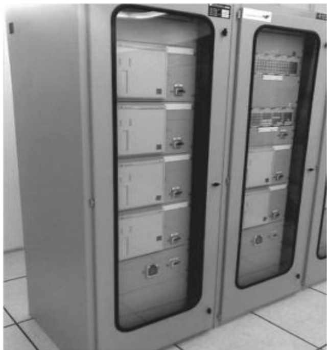
Рис. 4.7. Терминалы МУРЗ, установленные в стандартных шкафах со стеклянными дверями
