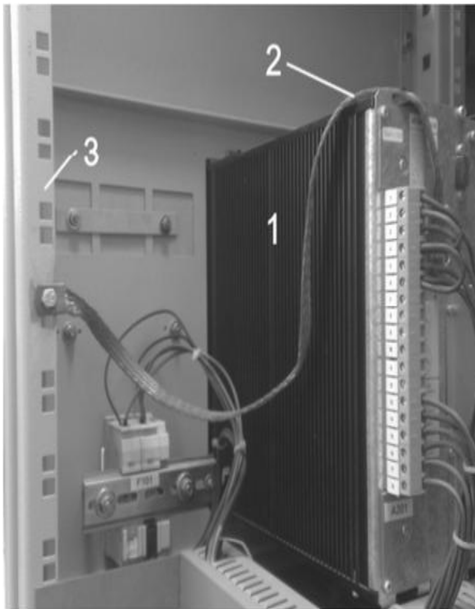
Рис. 4.2. Устройство заземления МУРЗ, установленных в металлических шкафах, с использованием эквипотенциальной поверхности. 1 - МУРЗ в металлических корпусах; 2 - заземляющие медные шинки; 3 - элемент конструкции металлического шкафа, выполняющего роль эквипотенциальной поверхности
